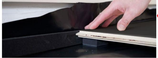
使用墊塊確保地板距離牆壁10mm，或選擇安裝塑料條。
