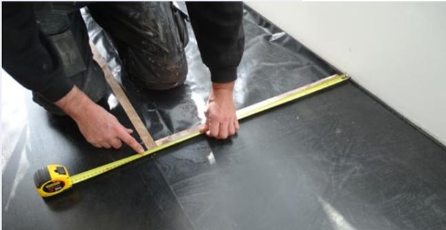
將地板切割成合適尺寸，如果需要請去掉底墊，然後用砂紙打磨任何粗糙的邊緣。保留地板的剩餘部分作為第二行的開始。
